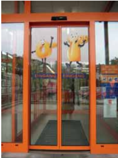
Bild 18: Durch Klebefolien kenntlich gemachte Glasflächen
